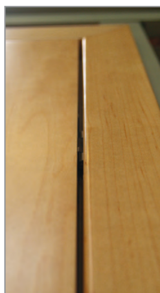
Türblatt und Zarge flächenbündig Flush door leaf & frame
