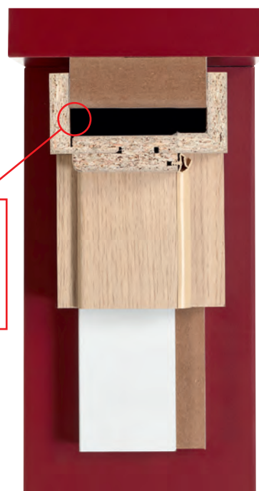
Blockrahmen Easy zwischen der Wandlaibung Block frame "Easy" (in window reveal)
