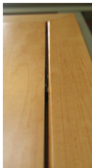
Türblatt und Zarge flächenbündig Doorleaf & frame flush
